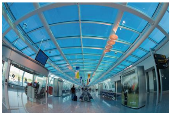
Brasil: TROX swirl diffuserer distribuere frisk luft til hallene og korridorer av Rio de Janeiro Santos Dumont lufthavn.
